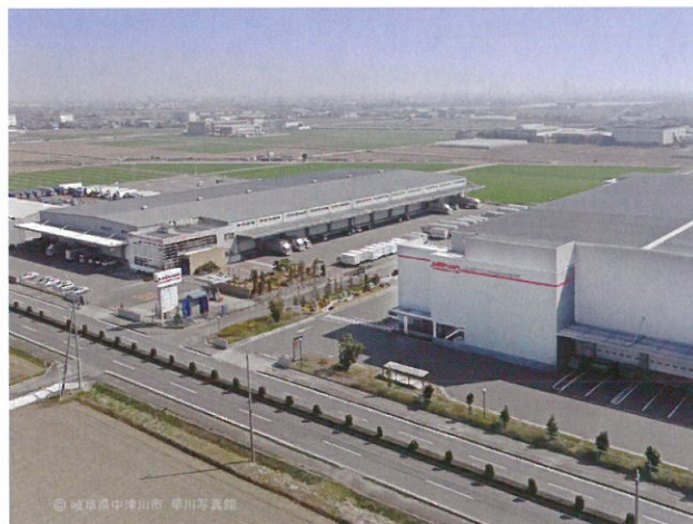
名正運輸の本社と物流センター。ここには、第1物流センター、中京物流センター、飛島第二センターがある
